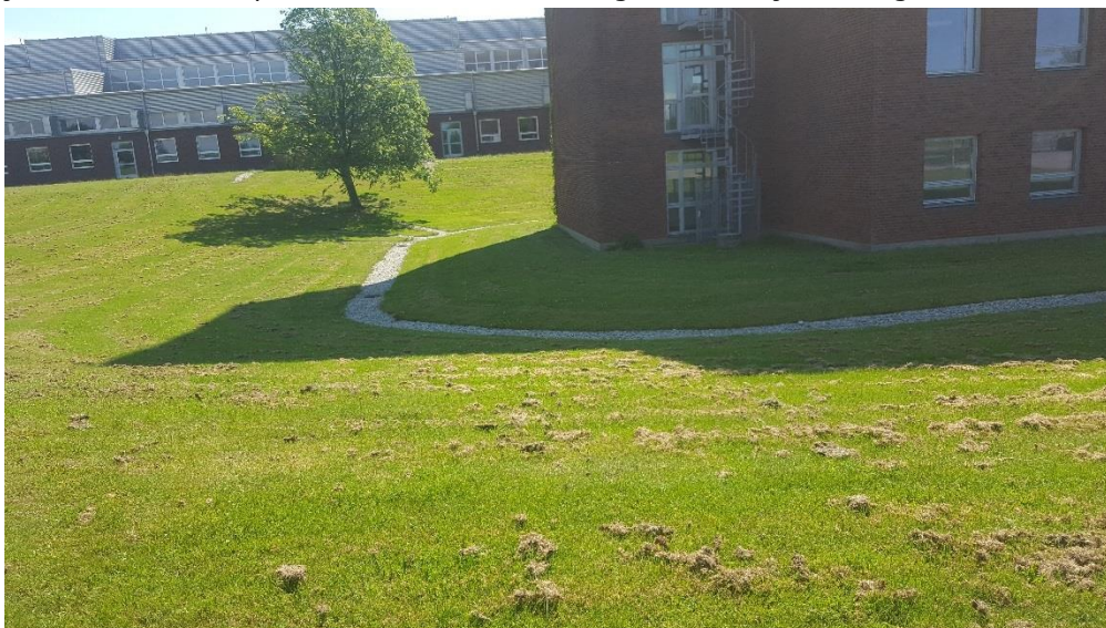
Figur 10. Exempel makadamdike kring byggnad, foto Ramböll.
